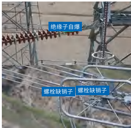
图2.11 基于图像识别技术的输电本体缺陷识别
